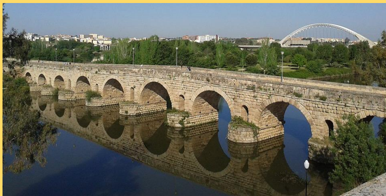
Ponte romano di Merida
